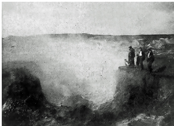
Fot. 105. Pałący się biedaszyb w Siemianowicach
