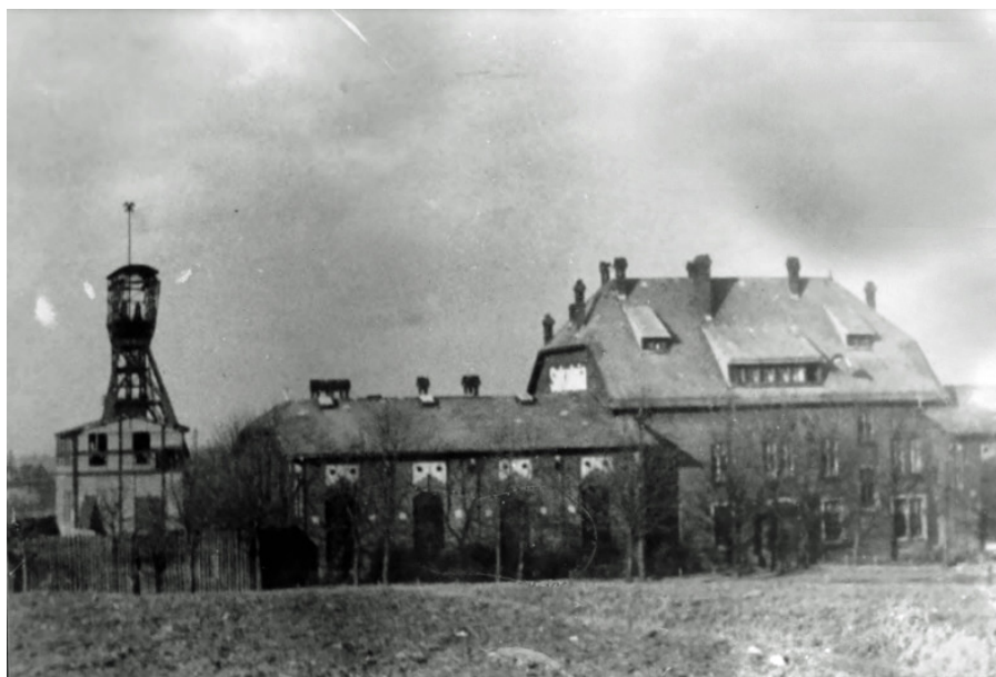
Fot. 60. Budynek „Sokolni” na terenie byłej kopalni „Knoff”
