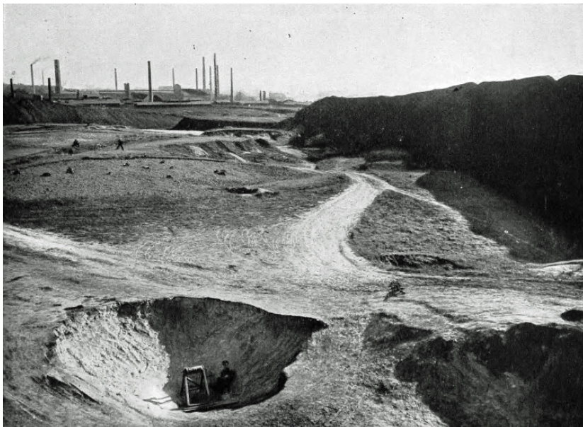
Fot. 112. Biedaszyb w okolicach Siemianowic. Na dalszym planie widoczna huta cynku należąca do Zakładów Hohenlohego w Wełnowcu
