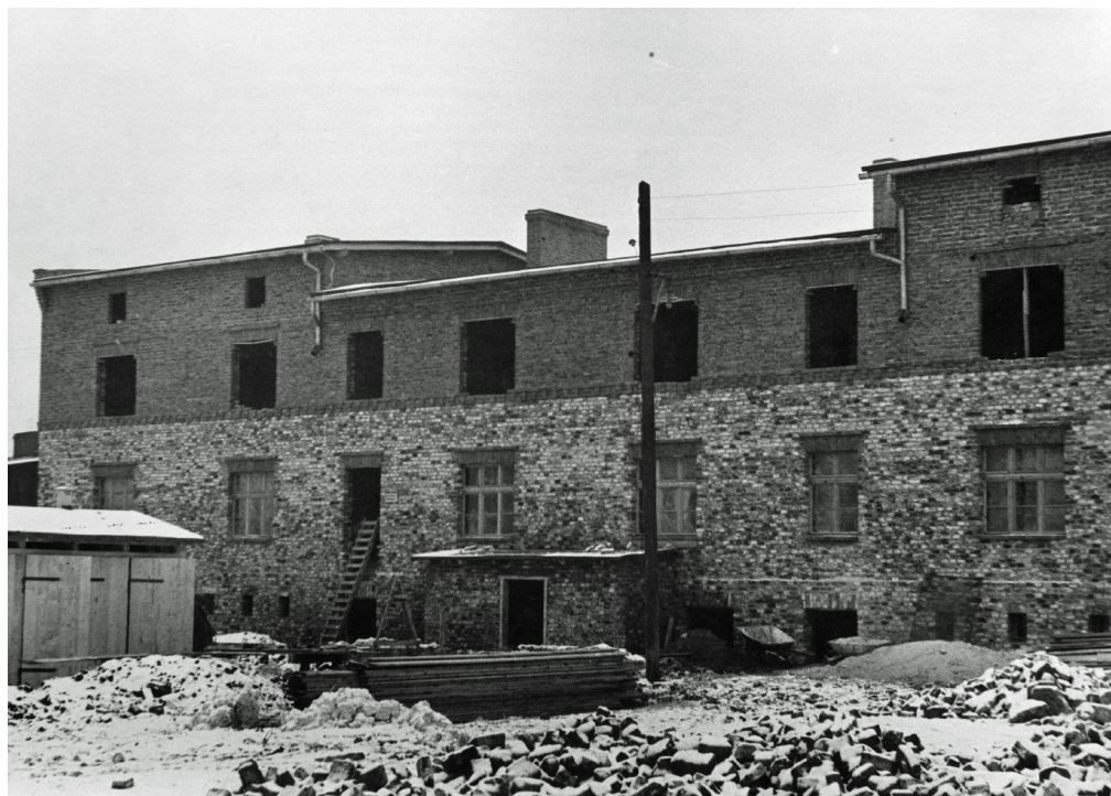
Fot. 238. Dąbrówka Mała. Budowa domu dla bezdomnych
