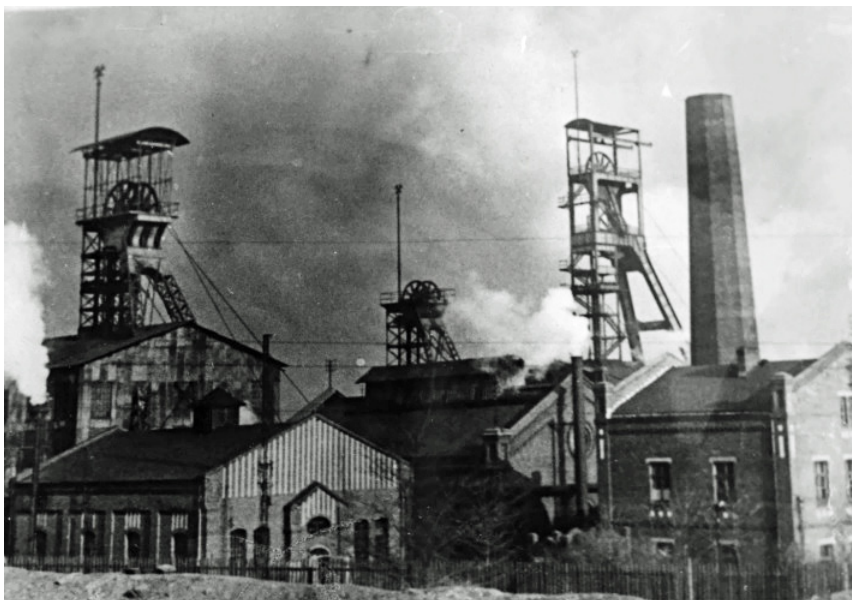
Fot. 31. Kopalnia „Siemianowice” (wcześniej „Richter”)
