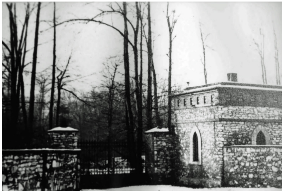
Fot. 70. Budynek dawnej portierni przy tamtejszym parku
