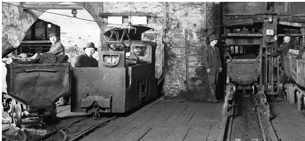
Fot. 23. Podszybie szybu „Richter III”. Transport urobku pod ziemią
