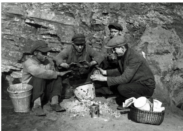
Fot. 131. Bezrobotni z biedaszybów grzejący się przy ognisku, przy którym zgotowali sobie strawę
