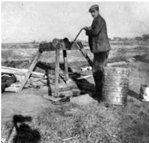
Fot. 85. Zakładanie biedaszybu. Na drugim planie widoczne deski służące do obudowy szybu
