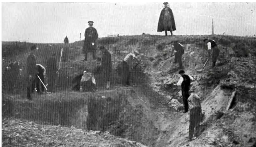
Fot. 166. Zasypywanie biedaszybów pod okiem władz
