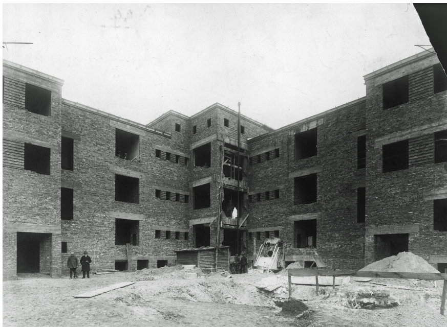
Fot. 207. Budowa azylu dla bezdomnych w Katowicach (1928 rok)
