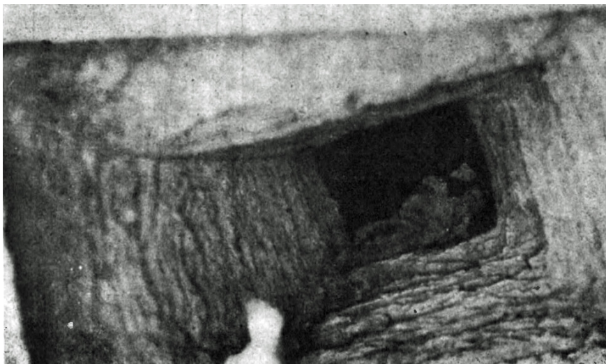
Fot. 84. Przekrój niezabezpieczonego szybiku. Często groził on zasypaniem
