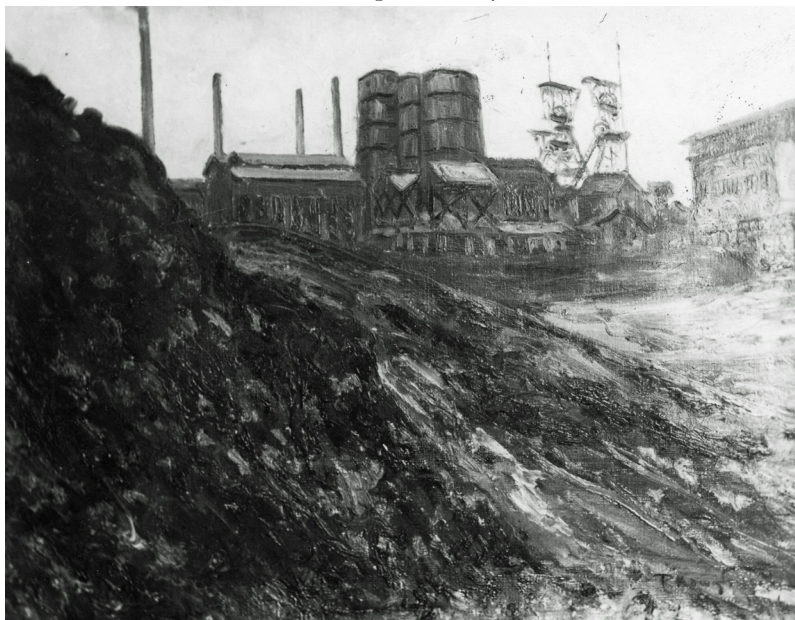
Fot. 211. „Kopalnia Ferdynand”
