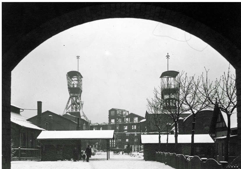
Fot. 26. Wieże szybowe kopalni „Knoff”. Na szczególną uwagę zasługuje brak kół na jednej z nich oraz widoczna rozbiórka infrastruktury (na dalszym planie).
