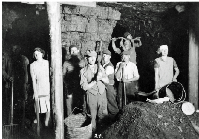
Fot. 89. Wewnątrz wełnowieckiego biedaszybu. Na fotografii widoczne są filary w kształcie litery „T”
