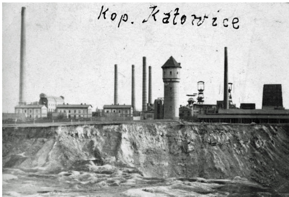
Fot. 210. Kopalnia „Ferdynand” („Katowice”) z okoliczną zabudową
