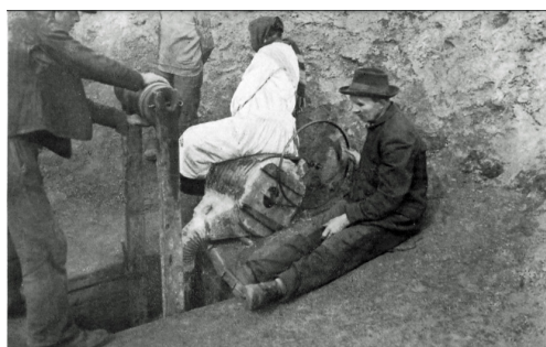
Fot. 88. Wentylator z ręcznym napędem włączający świeże powietrze do kopalni
