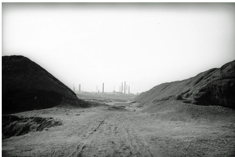
Fot. 117. „Czarne hołdy”. W oddali widoczna huta należąca do Zakładów Hohenlohego
