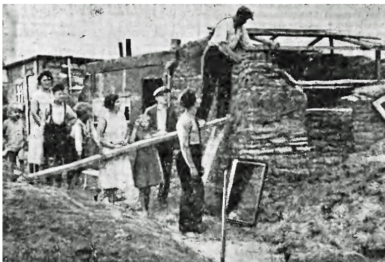
Fot. 233. Podczas budowy „domu”
