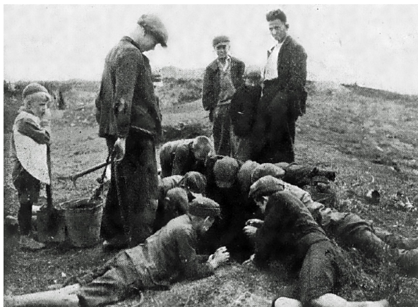
Fot. 102. Obserwatorzy kopania szybu w Siemianowicach
