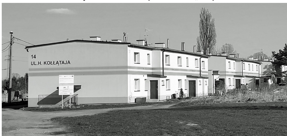
Fot. 291. Ocieplona zabudowa dawnych baraków na „Nowym Świecie”
