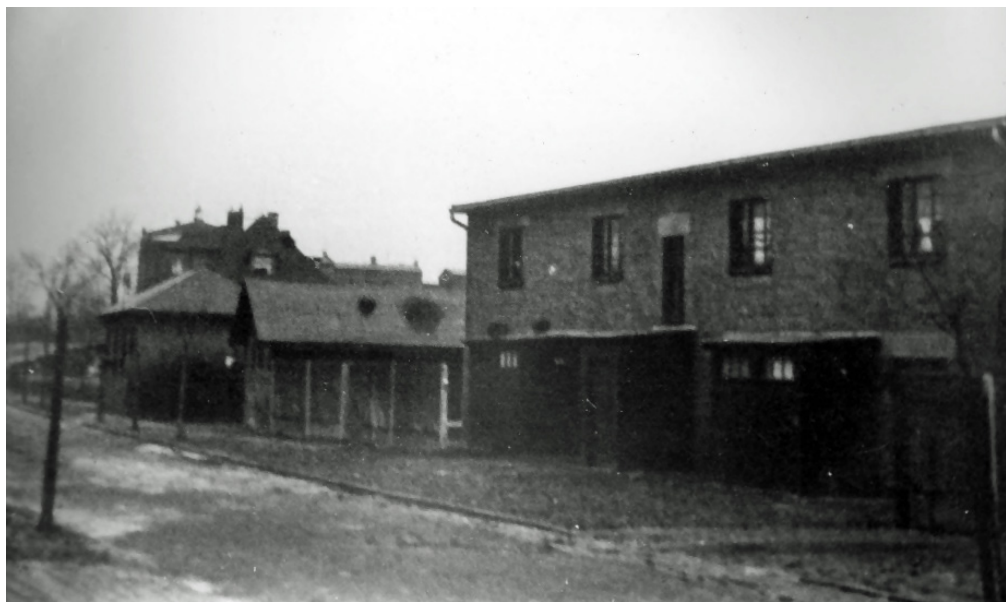
Fot. 200. Baraki mieszkalne przy ulicy Kilińskiego przeznaczone dla bezdomnych z siemianowickich lepiarek. W oddali dostrzec można istniejącą do dziś kamienicę przy ulicy Cmentarnej
